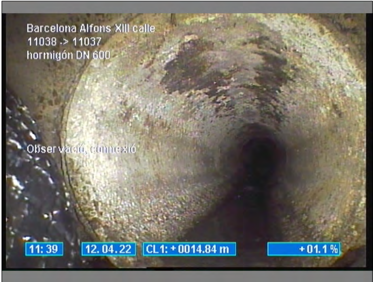
Foto: 2_4A 14,8m, Observació, connexió
