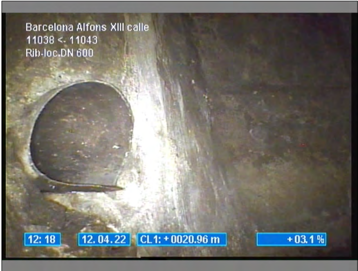
Foto: 4_2B 20,9m, Observació, connexions al dos costats
