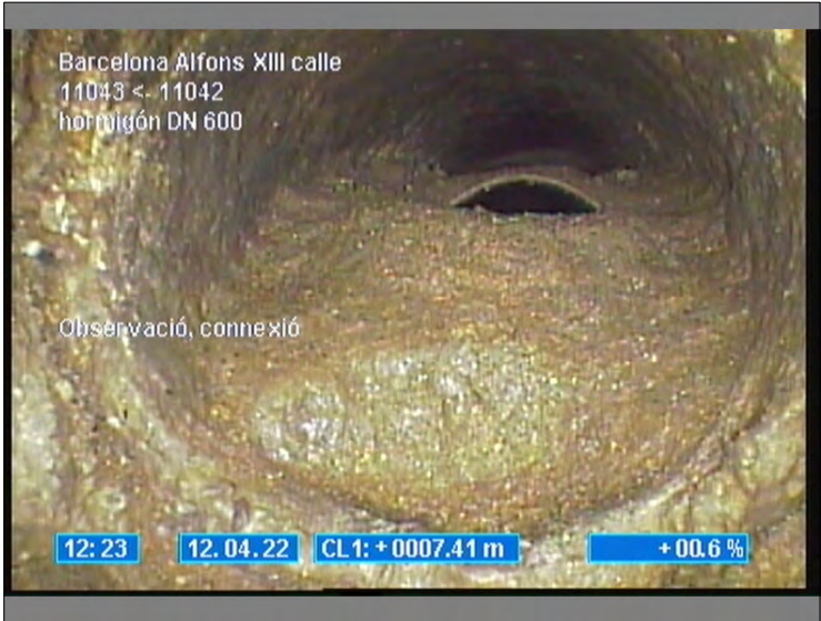
Foto: 5_3A 7,4m, Observació, connexió
