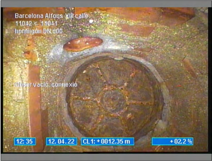
Foto: 6_2A 12,3m, Observació, connexió
