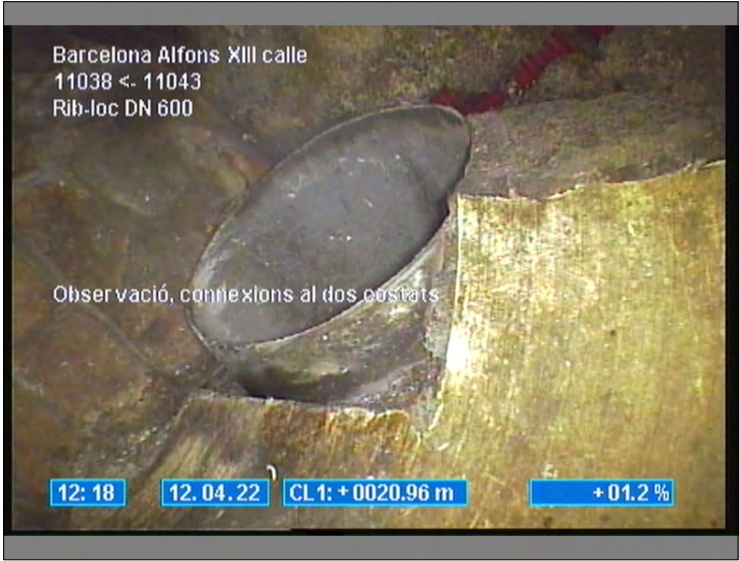
Foto: 4_2A 20,9m, Observació, connexions al dos costats
