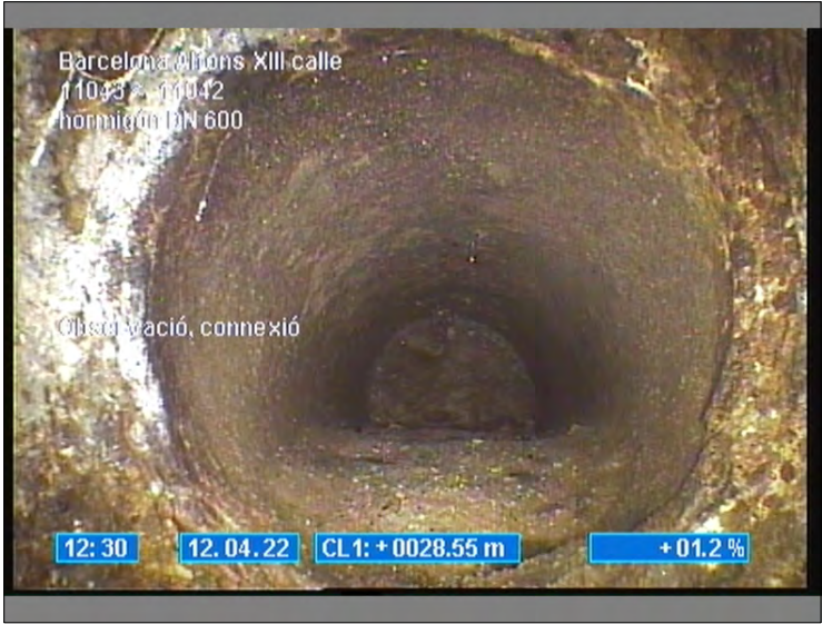
Foto: 5_8A 28,5m, Observació, connexió
