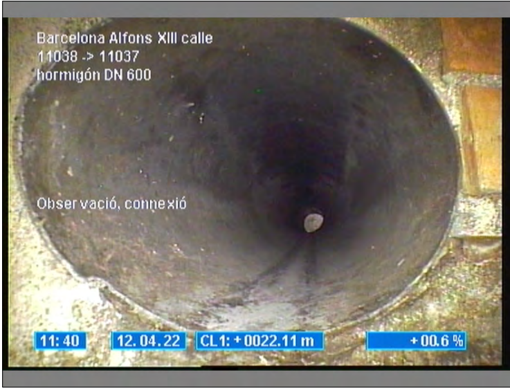
Foto: 2_5A 22,1m, Observació, connexió
